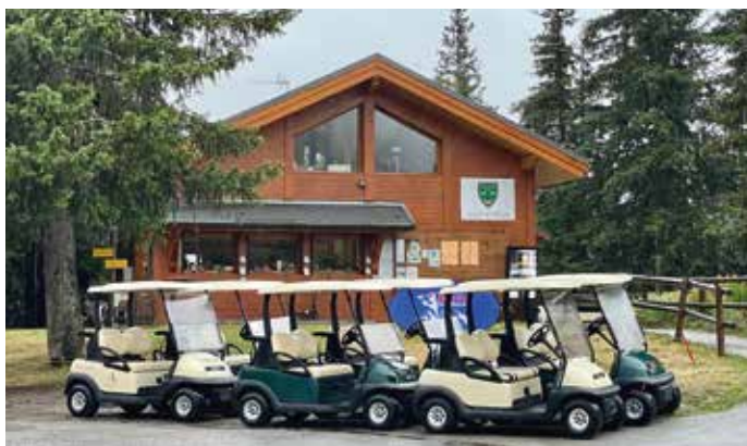
Les travaux du club-house démarreront dès octobre 2025.
